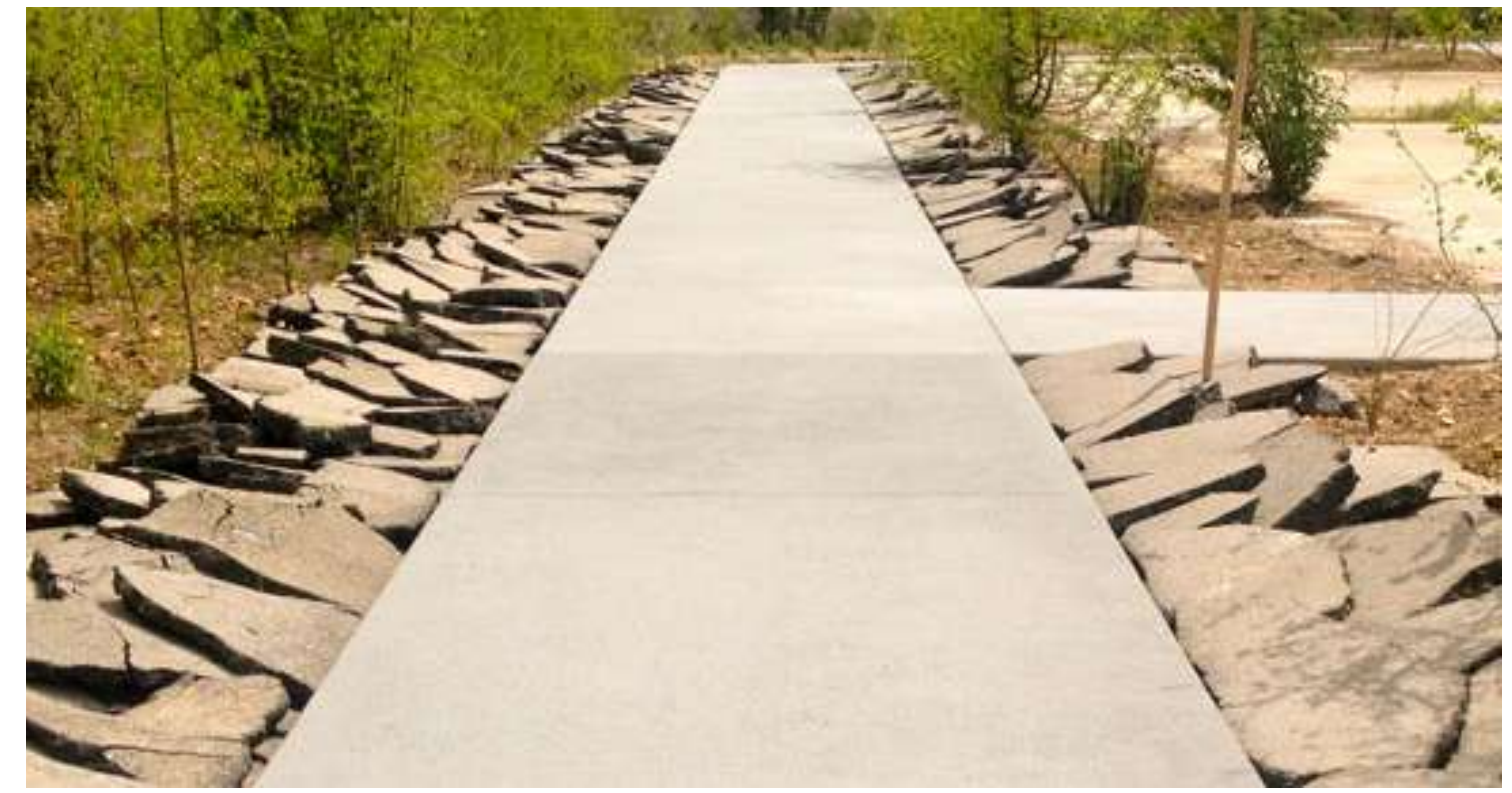
Banquette en plaques d'enrobé le long d'un cheminement
