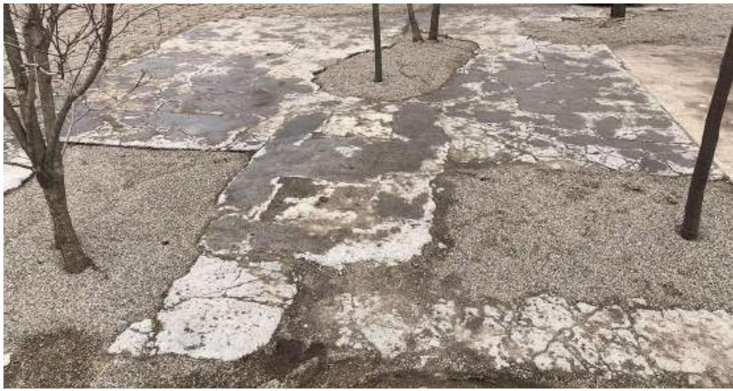
Traces de fondations
